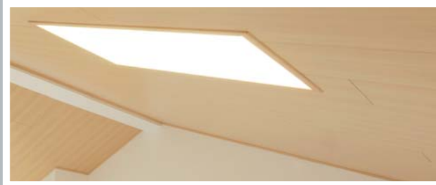
Paso 6: Colocación de moldura perimetral
