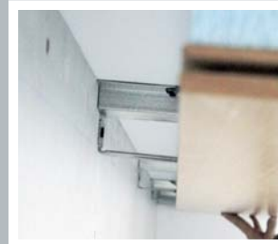
Paso 4: Instalación del panel Thermochip® Deco
