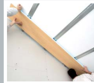
Paso 4: Instalación del panel Thermochip® Deco
