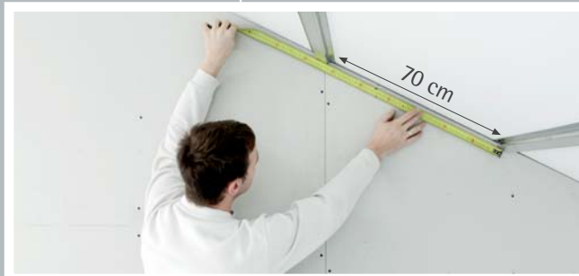
Paso 2: Colocación de perfilería
