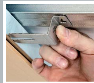
Paso 5: Colocación de pieza de fijación
