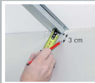
Paso 3: Colocación de pieza de arranque
