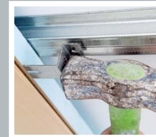
Paso 5: Colocación de pieza de fijación
